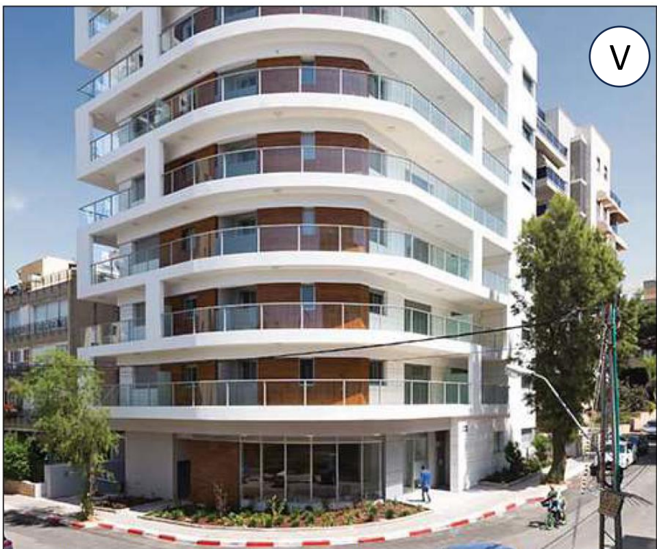
לובי שקוף הפונה לרחוב. רחוב האשל, רמת גן. מילבאואר אדריכלים.
