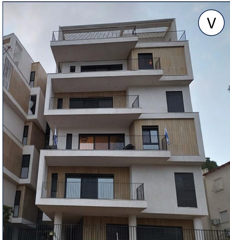
טיח בשילוב חיפוי דמוי עץ. רחוב יותם, חיפה. פלוק אדריכלים.
