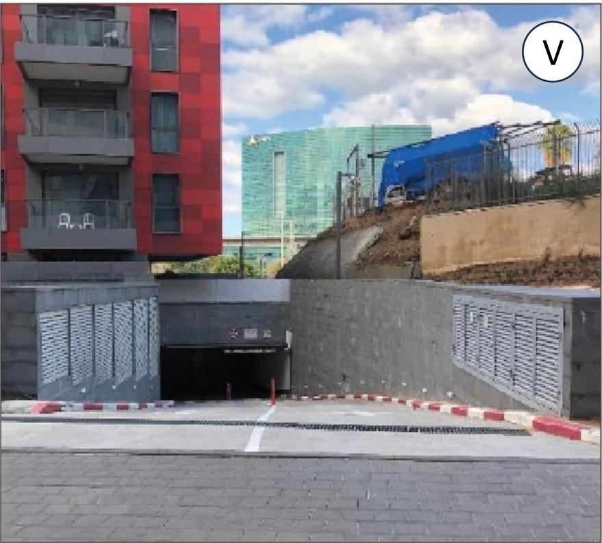
הצנעת מערכות בכניסה לחניון. הרצליה הילס, קיקה בראז אדריכלים.
